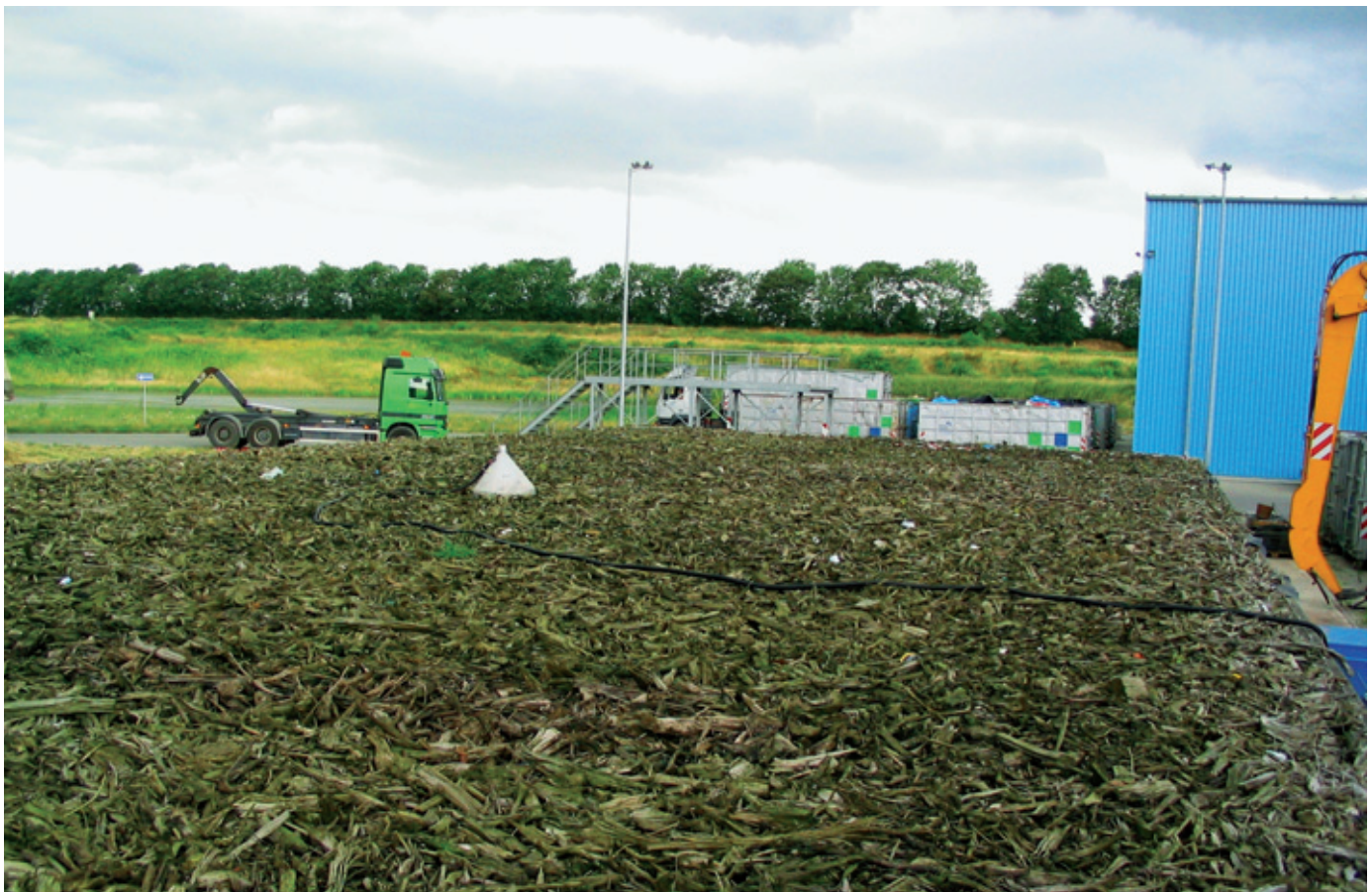
Foto 6. Puulaastudega biofilter jäätmekäitlustehases Saksamaal.
