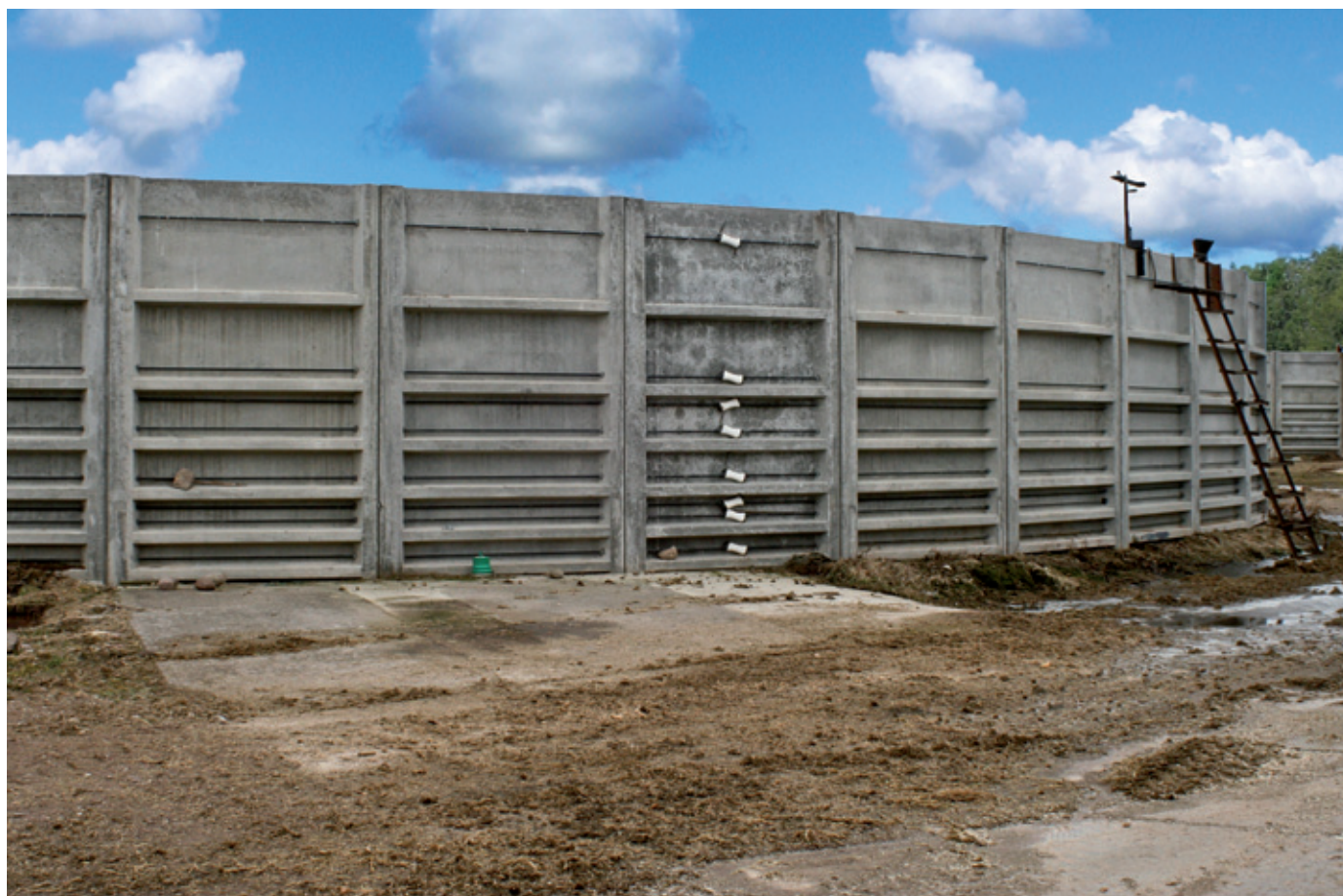
Foto 3. Sõnnikuhoidla, mis vastab PVT nõuetele.
