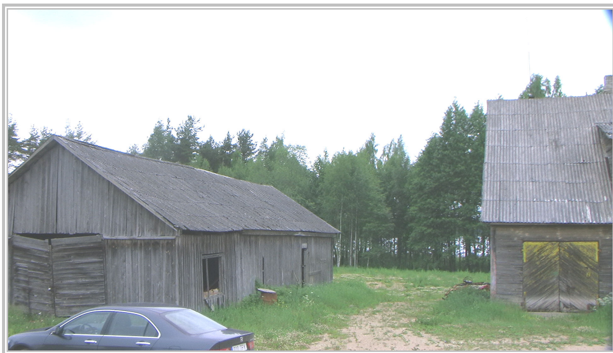
Foto 1 Vaade krundile sissesõiduteelt.
